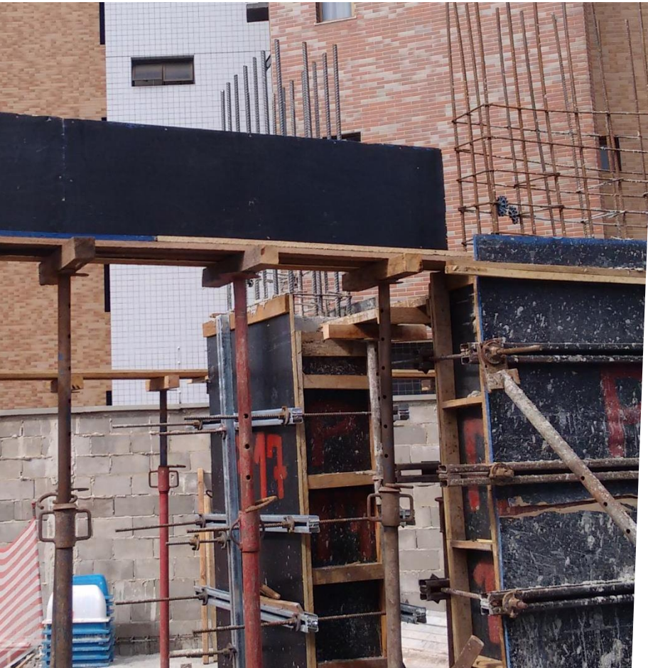
Convencional Fôrma da viga de madeira
